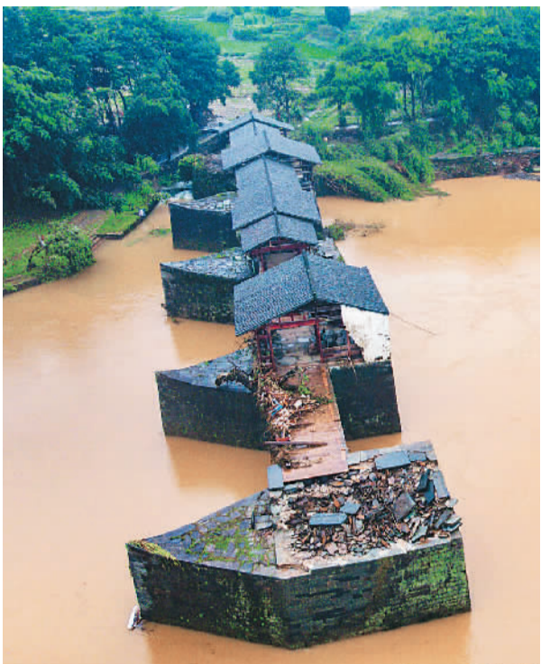
左图：7月10日，在江西省婺源清华镇拍摄到的遭洪水冲毁的彩虹桥。
