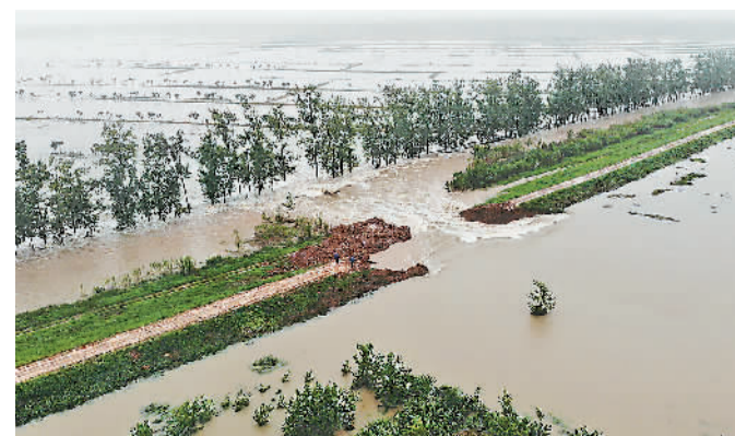
7月19日,安徽滁河实施爆破泄洪,启用两处蓄洪区。 新华社记者 黄博涵摄
