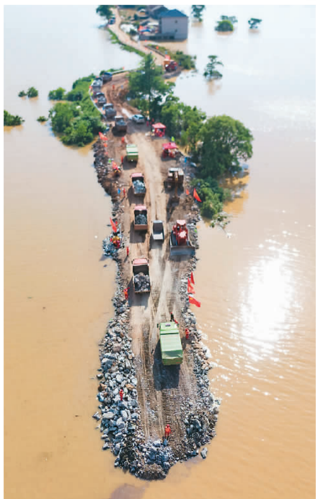
▲ 江西省鄱阳县鄱阳镇问桂道圩堤抢险施工现场。 新华社记者 周密摄
