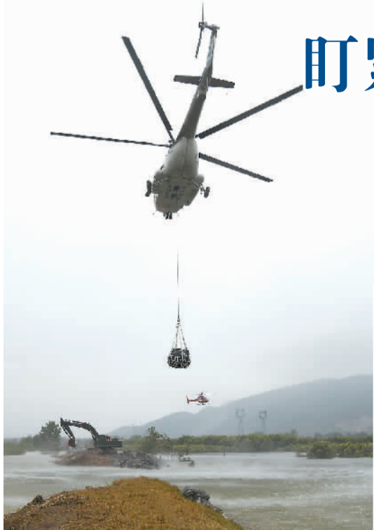
大图:7月16日,湖北省应急管理厅紧急调度的直升机在富河干堤蔡寨湖下坑溃口上空空投网兜石块。
