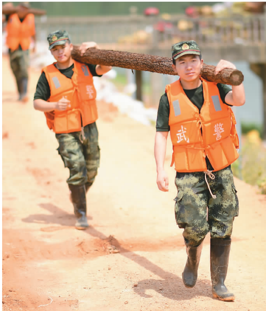
7月13日,武警江西总队机动支队官兵在江西省鄱阳县双港镇双丰村赵家湾水库堤坝上搬运木材,加固子堤。曹先训摄(人民视觉)
