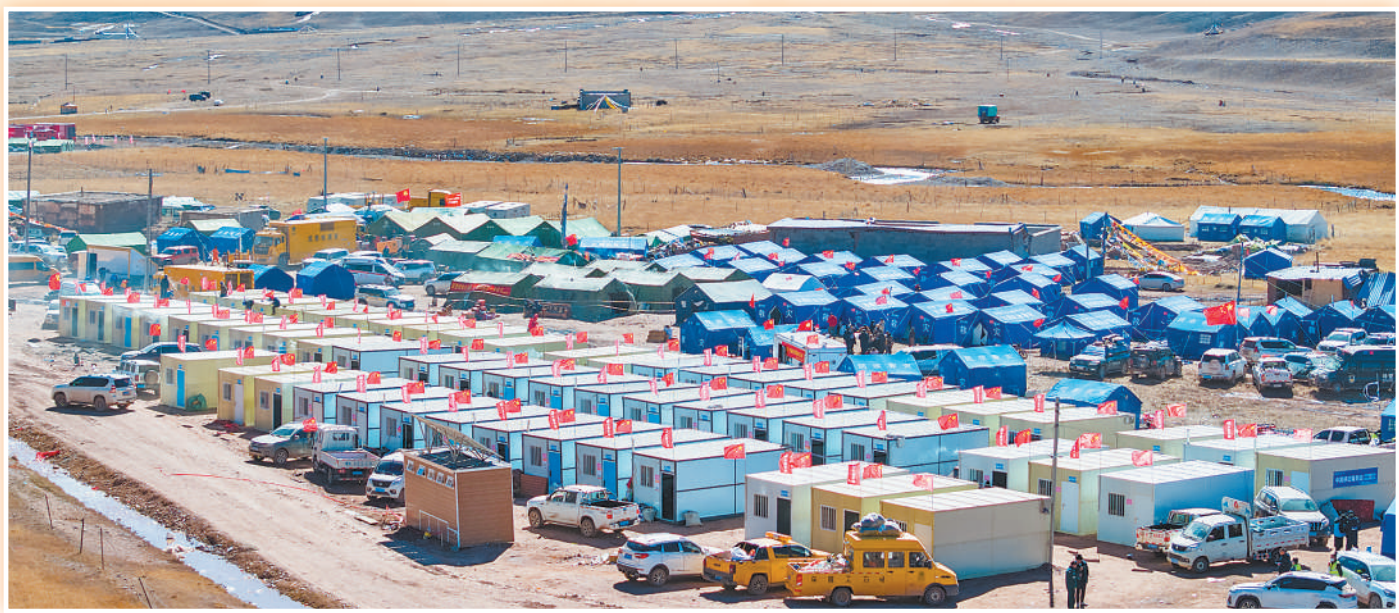
上图:10月26日,巴青县玛如乡二村安置点已经搭建好的板房全貌。 本报记者 徐驭尧摄
