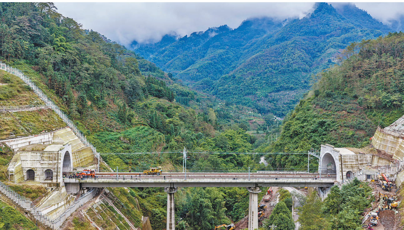
本报昭通10月24日电 (记者叶传增)渝昆高铁24日全线铺轨完成。渝昆高铁是我国“八纵八横”高铁网京昆通道的重要组成部分,线路起自重庆西站,途经重庆市、四川省、贵州省和云南省,接入昆明南站,全长约700公里,设计时速350公里。 图为渝昆高铁筠连隧道口施工现场。 新华社记者 胡超摄
