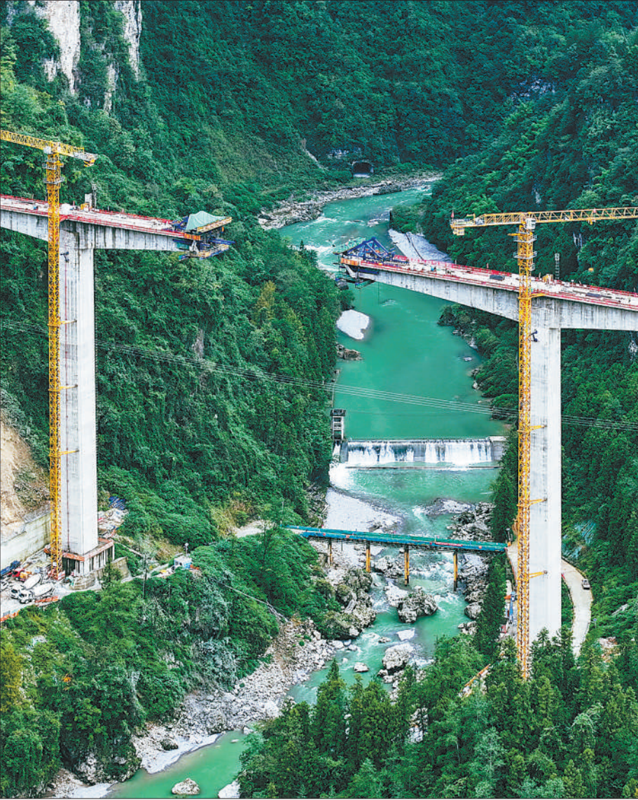
湖北恩施,姚家平水利枢纽工程一号交通桥施工现场一派繁忙。 张远明摄(影像中国)
