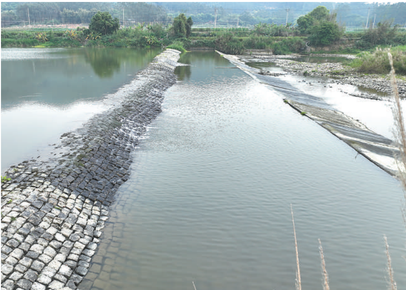
▲龙津古陂颜厝陂渠首拦河坝。 福建漳州市长泰区水利局供图
