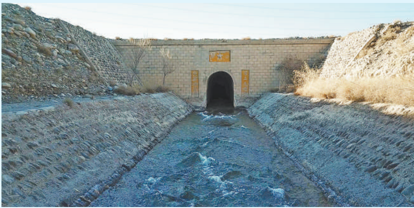
▲尚在使用的明清洪水河洞子渠(洪水河东干渠引水隧洞出口)。 ▲明清洪水河洞子渠(洪水河东干渠引水隧洞内部)。 以上图片均为甘肃省水利厅提供
