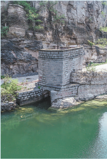
▲作为沁河广利渠(五龙口)组成部分之一的广惠渠首闸。 ►沁河广利渠(五龙口)渠首引水闸。 以上图片均为河南焦作市水利局提供
