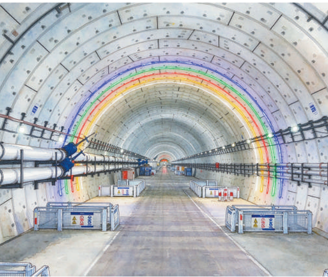
海太长江隧道成型隧道。
