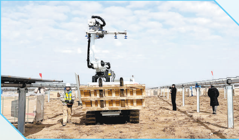
▲中方工作人员为老挝国家输电网公司老挝学员讲解无人机操作。 蔡兴文摄 ►乌兹别克斯坦纳沃伊综合能源300兆瓦光伏项目光伏组件智能安装机器人正在作业。 中国能建海投公司供图 ▼晨雾山峦间的中老500千伏输电线路（老挝段）。 南方电网调峰国际公司供图
