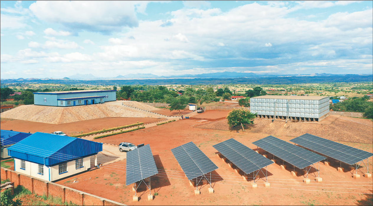
马拉维利隆圭蚌达供水管网优化项目泵房及蓄水池区域航拍图。
