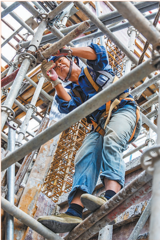
江苏南京河海大学五期学生公寓建设项目现场,工人在加固脚手架。 白光迪 张梦摄影报道
