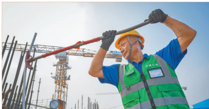
河北雄安新区中国人民大学大中小学教育一体化综合改革示范基地项目,工人在绑扎钢筋。 人民网记者 李兆民摄
