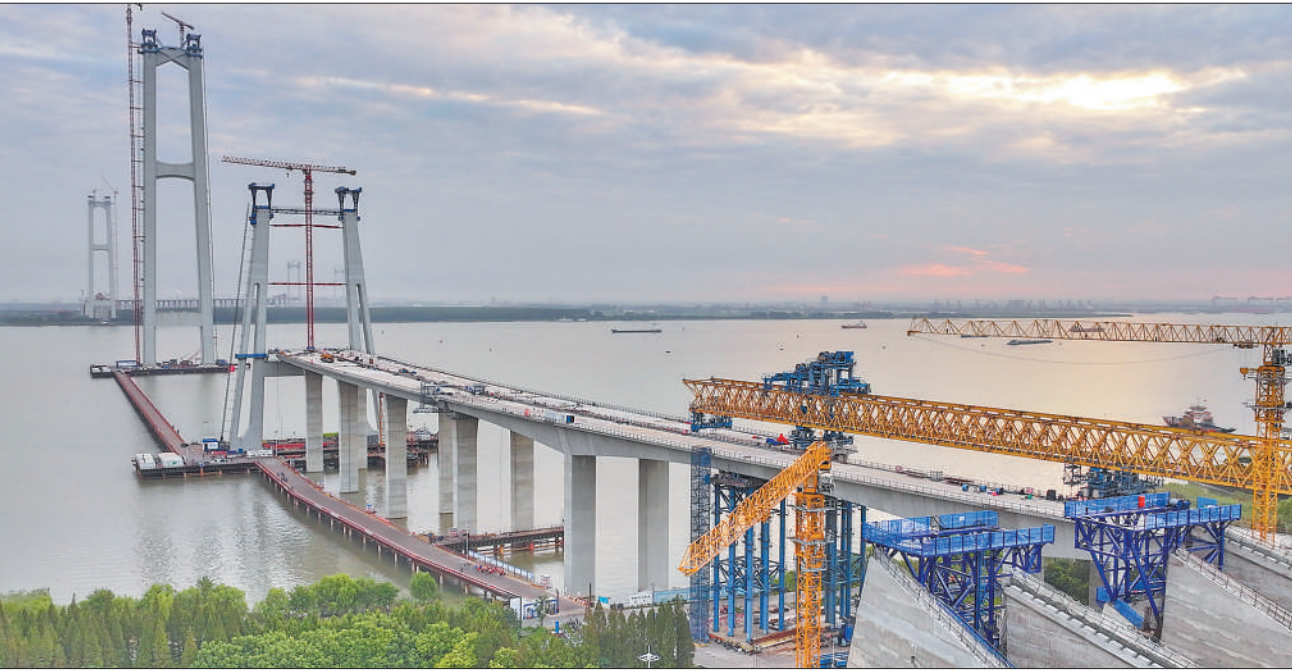
9月13日，江苏省张家港市张靖皋长江大桥南航道桥施工正在推进，大桥建成后将助力长三角一体化高质量发展。 施柏荣摄（影像中国）
