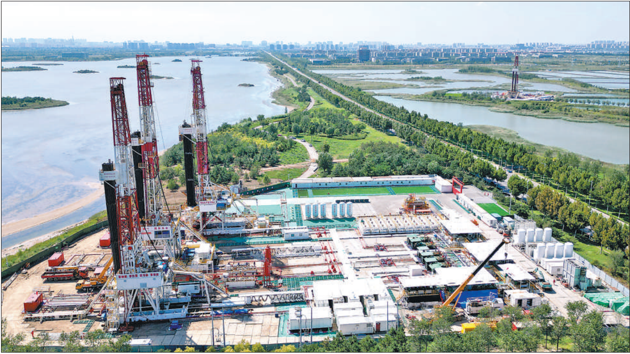
胜利油田依托“数据+平台+应用”新模式,成功研发了全面信创技术栈大型应用系统——中国石化油气生产信息化平台,为油气田开发精细精益管理提供了数智化支撑。图为山东东营,胜利济阳页岩油国家级示范区一页岩油井工厂。 郑跃光摄(影像中国)
