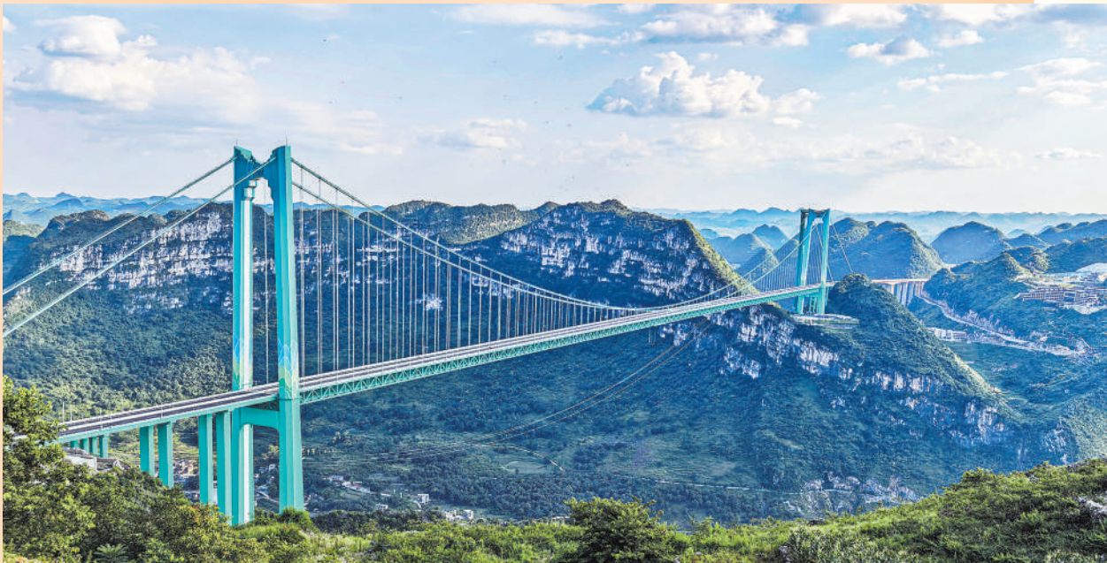
2025年9月28日，横跨贵州黔东南布依族苗族自治州贞丰县与安顺市关岭布依族苗族自治县的花江峡谷大桥建成通车。花江峡谷大桥主桥跨径1420米，居山区桥梁跨径世界第一；桥面距水面高度625米，同为世界第一。大桥通车后迅速成为热门旅游目的地，带动周边景区、民宿等人气升温。图为花江峡谷大桥。 吴东俊摄(人民视觉)
