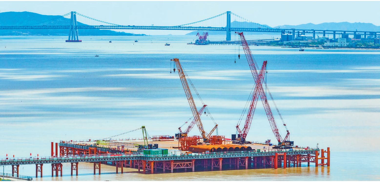
9月5日,新建温州至福州高速铁路瓯江公铁大桥北口航道桥32号主墩钢栈桥及钻孔平台全部搭设完成,为大桥水上主体工程建设奠定坚实基础。
