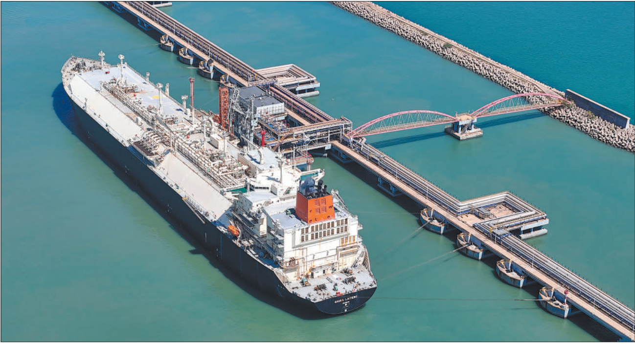
9月3日，一艘液化天然气（LNG）船靠泊山东青岛西海岸新区，中国石化青岛LNG接收站随即启动接卸作业，8万余吨液化天然气陆续注入区域天然气保供资源池，为即将到来的用气高峰提前蓄能。 张进刚摄（人民视觉）
