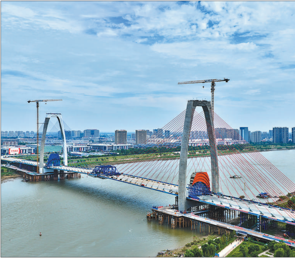
9月3日，随着合龙段钢箱梁精准吊装就位，安徽蚌埠延安路大桥主桥顺利合龙，为全线通车打下基础。延安路大桥是淮河流域跨径最大的斜拉桥，建成后 will 有效缓解当地交通压力，改变居民“绕路过河”的出行现状。
