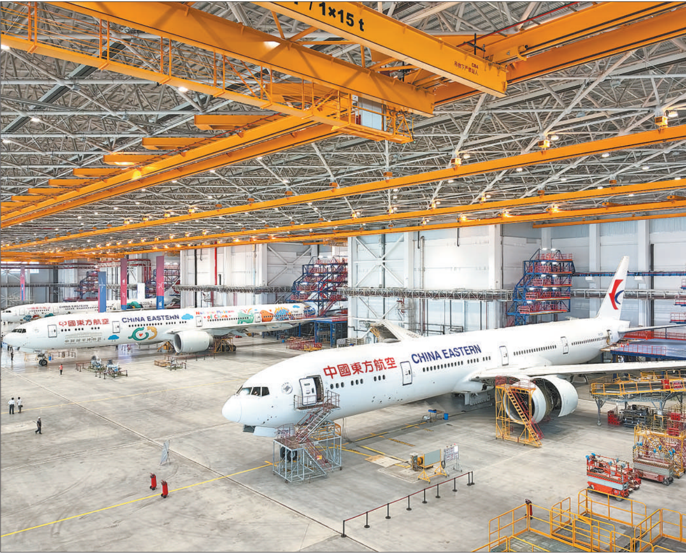
9月2日,亚洲最大宽体机维修机库在上海投入运营,该机库大厅可以同时容纳9架宽体机和2架窄体机开展整机维修作业。图为维修机库内部。
