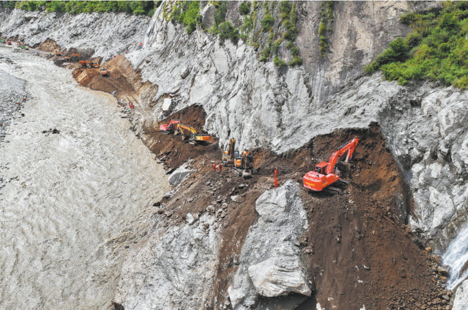
9月1日，中国安能救援力量在距离吉隆口岸700米位置的216国道抢修道路。 本报记者 张武军摄
