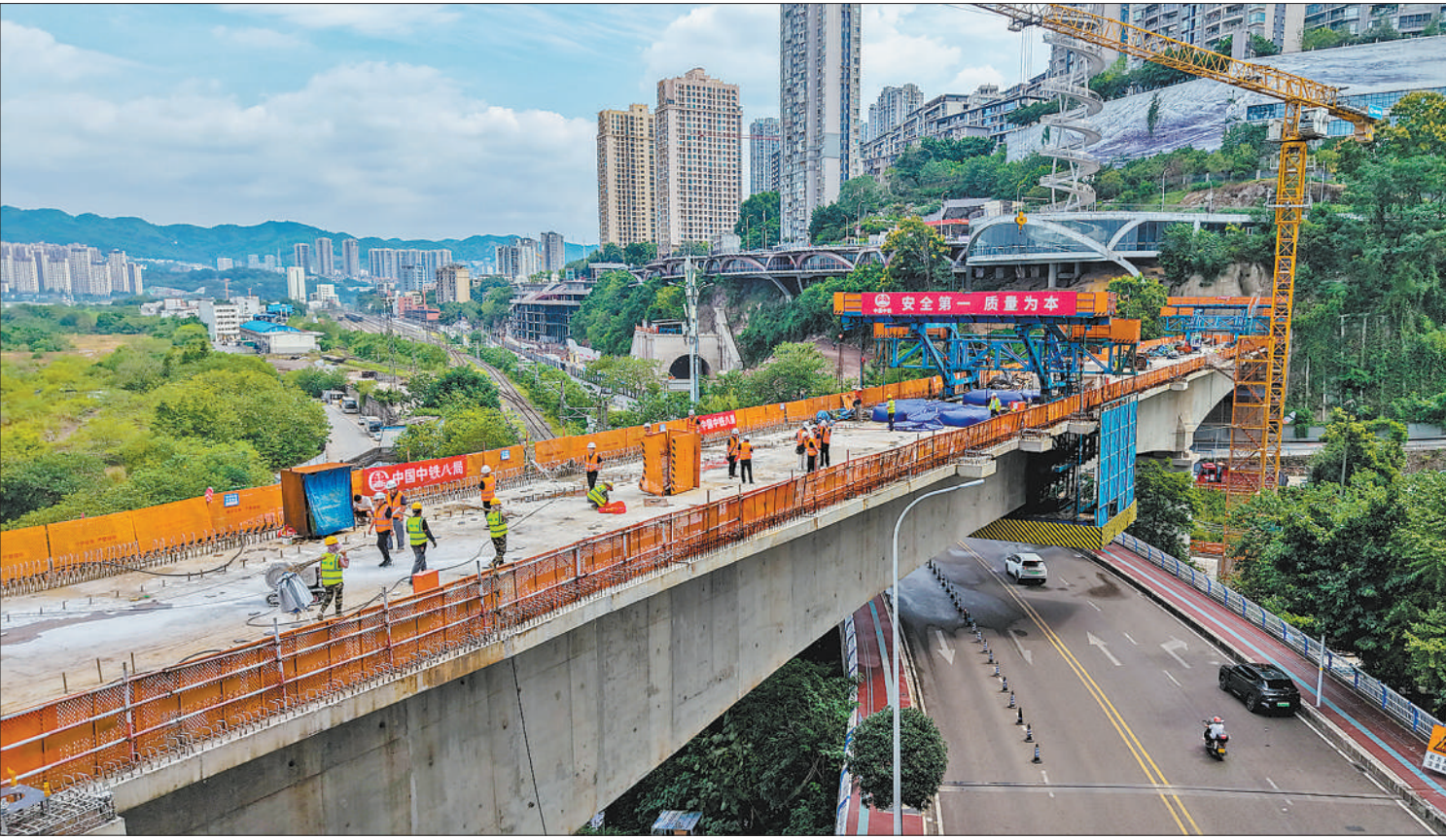
8月30日，成渝铁路改造工程黄桷坪双线特大桥顺利合龙，为项目后续建设打下坚实基础。黄桷坪双线特大桥坐落于重庆市九龙坡区，是成渝铁路改造工程全线的控制性关键工程。大桥总长754米，此次完成合龙的是桥梁主跨连续梁部分，后续还将推进站房段、箱梁段施工。图为黄桷坪双线特大桥建设施工现场。
