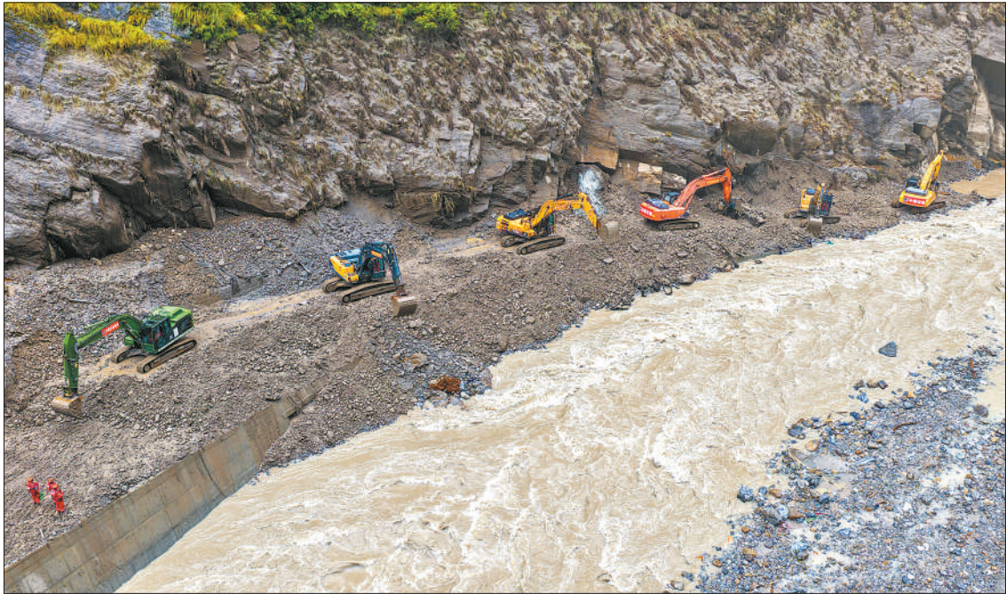
救援人员正在抢修道路。
