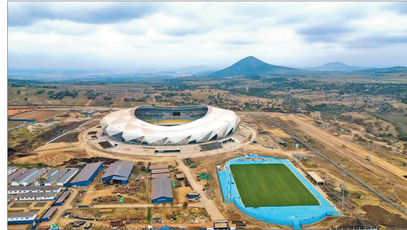
日前，由中铁建工集团有限公司承建的坦桑尼亚阿鲁沙综合体育场建设进度超过90%，主场施工进入收尾阶段。该体育场预计可容纳3万余名观众，将成为坦桑尼亚国家级体育场、2027年非洲杯比赛场地，对完善当地体育基础设施、提升国际赛事承办能力具有重要意义。图为项目航拍。
