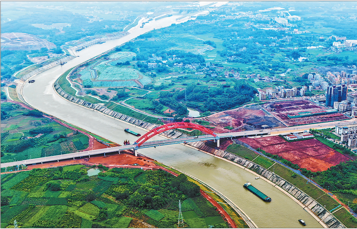
8月19日,广西平陆运河实船试验持续推进,5000吨级重载、5000吨级空载、3000吨级重载、1000吨级重载4艘代表船型集结编队,开展企石枢纽至青年枢纽下行航道综合科目试验,检验航道、锚地、青年枢纽船闸的实际通航表现,为9月通航提供技术保障。图为试验船舶有序航行。
