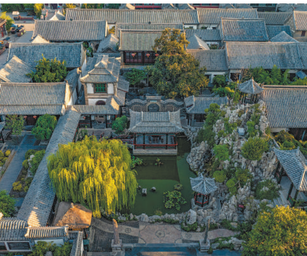
山东潍坊十笏园博物馆航拍。
