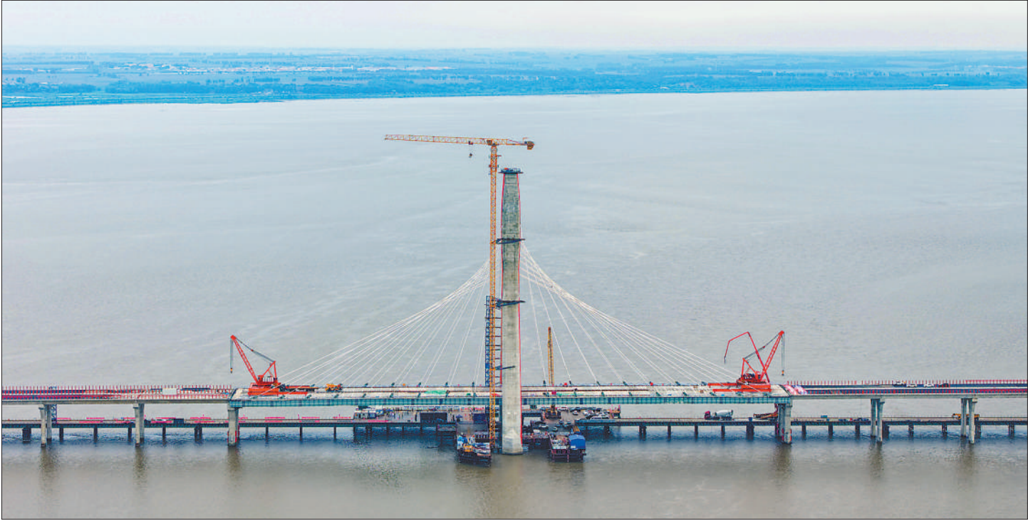
8月18日，黑龙江哈尔滨市都市环线北环永源至双井段重点控制性工程——松花江特大桥顺利合龙，实现北环项目核心节点全线贯通，为后续通车筑牢基础。松花江特大桥全长4668.5米，项目建成后，将进一步完善哈尔滨市圈高速路网体系。新华社记者 张涛摄
