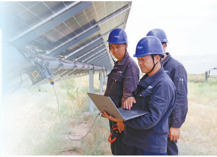
▲中吉技术人员在楚河州100兆瓦光伏电站巡检设备。 本报记者 张志文 摄
