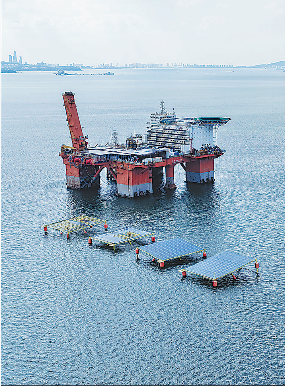
百千瓦级竹基海上光伏平台“集林二号”在山东烟台海上光伏实证检测基地完成安装。该平台对海洋生态环境影响小，有助于实现“绿电绿造”。
