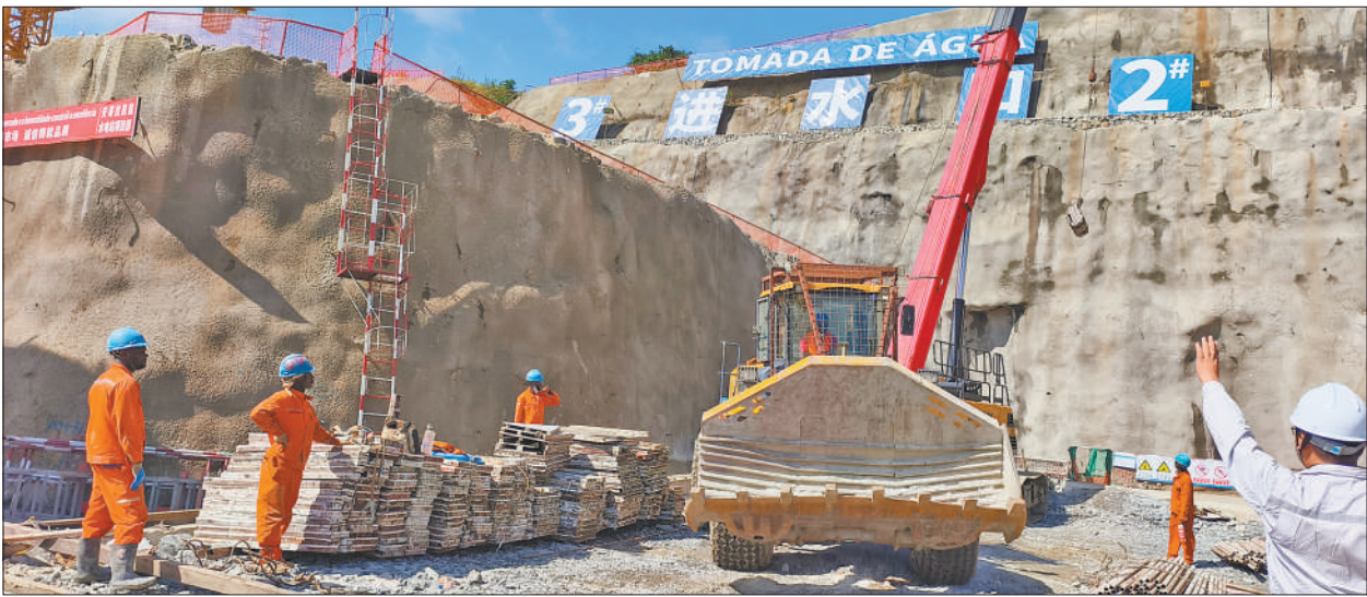
安哥拉凯凯水电站大坝的一处进水口施工现场。
