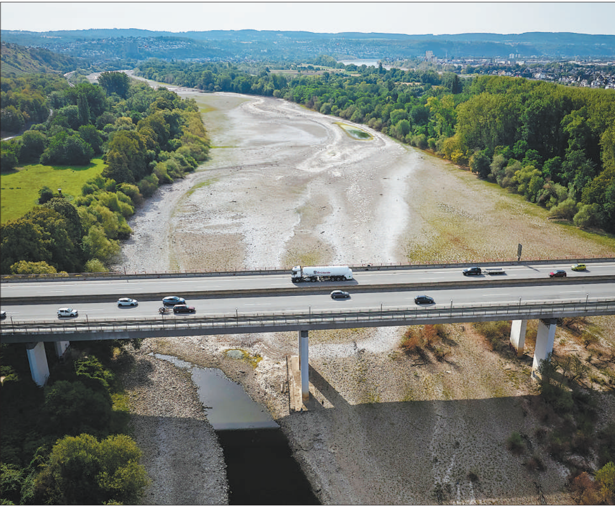
在德国本多夫附近,车辆行驶在高速公路上,桥下莱茵河大面积河床裸露。
