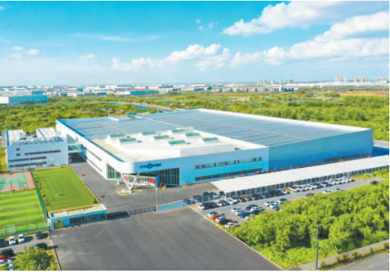
沈阳微控飞轮磁悬浮应用产业基地。郭延松摄
