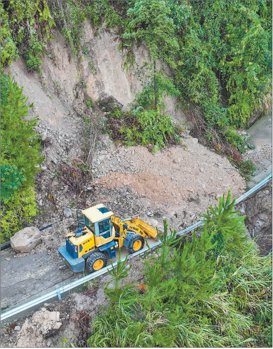
为应对台风“白海豚”带来的影响,浙江多地积极行动,做好设备抢修、路面清障等应急抢险工作。图为8月10日,工程机械在温州市永嘉县鹤盛镇抢修山区公路。新华社记者 江 汉摄
