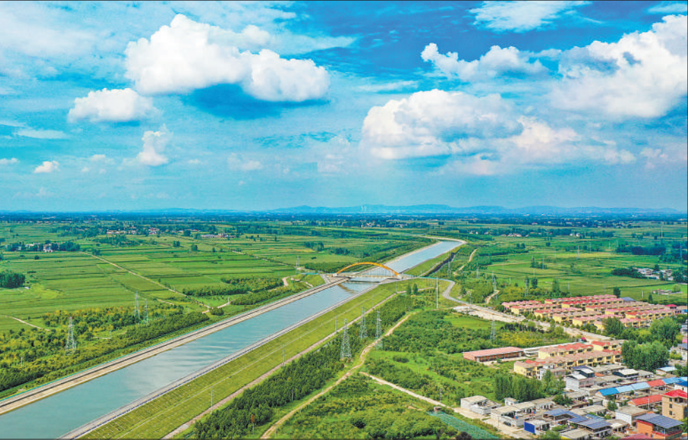
在南水北调中线工程河南叶县段,一渠清水流经田野与村庄。李洪坡摄(人民视觉)
