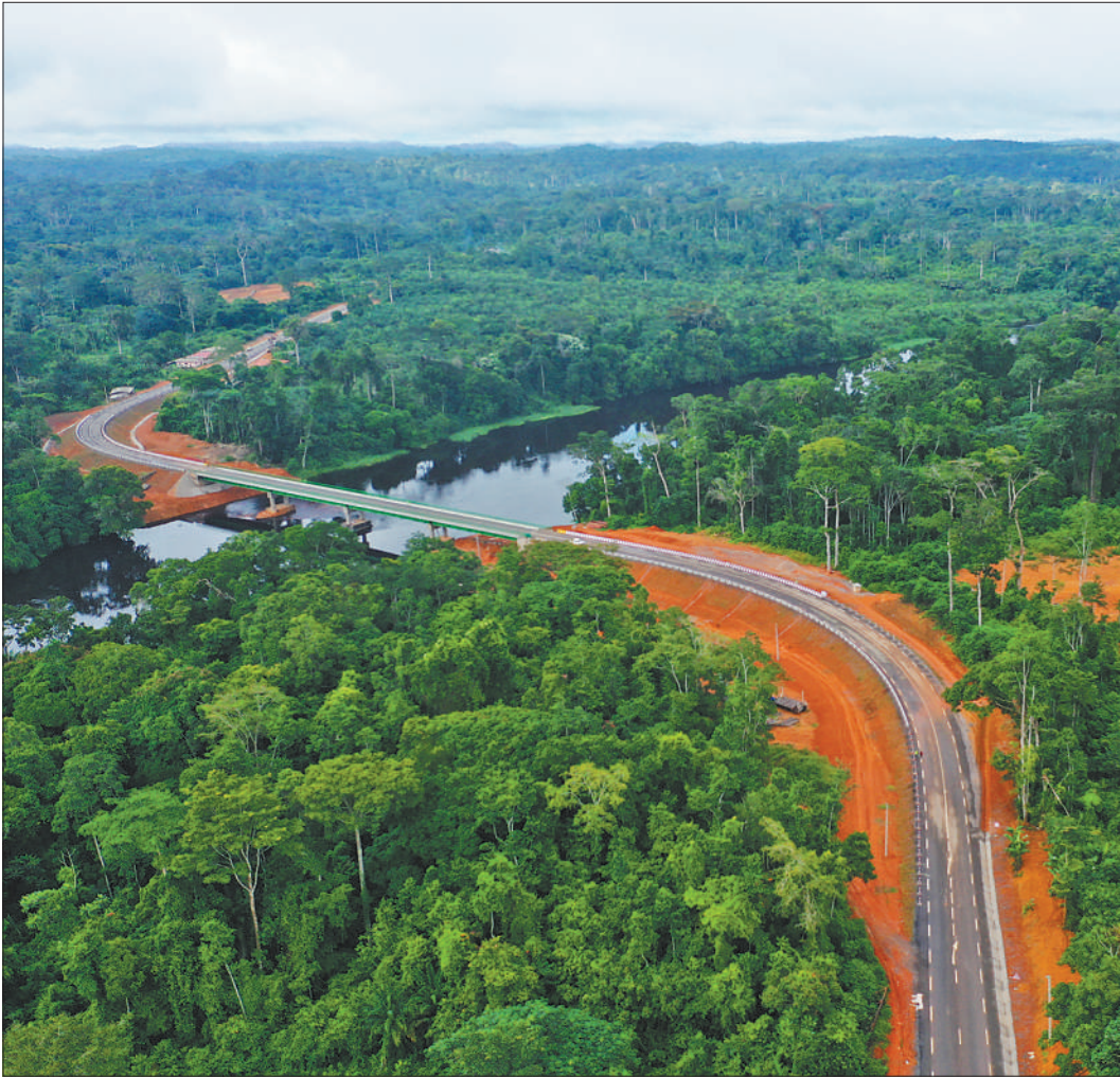
中交一公局集团承建的喀麦隆尼永河大桥日前建成通车。尼永河大桥从2024年6月开始建设，项目全线总长约1120米，其中桥梁全长160米，采用钢混组合梁结构，是当地路网的关键控制性工程，也是喀麦隆首座采用钢梁顶推工艺建设的桥梁。图为该项目航拍。
