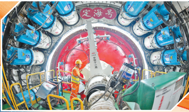
►南桥铁路金塘海底隧道建设者在进行盾构机主驱动检修。 张 玺摄(影像中国)
