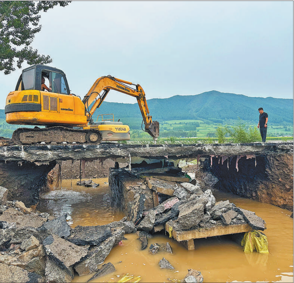
7月29日，吉林延边朝鲜族自治州汪清县出现强降雨，部分乡镇发生内涝，造成群众被困、道路损毁、供电中断等情况。强降雨过后，汪清县交通、通信、供电等抢修工作紧张有序展开。图为7月30日，在汪清县大兴镇，工作人员拆除损坏的路面。
