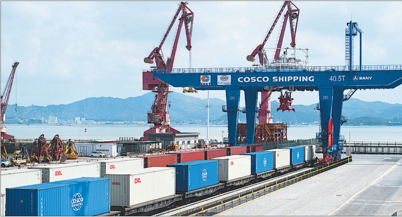
7月29日,一列满载集装箱的货运班列从厦门远海码头平稳驶出,全国首条“垂直岸线、直达码头”的海铁联运专用线——厦门远海码头铁路专用线正式通车。新华社记者 林善传摄
