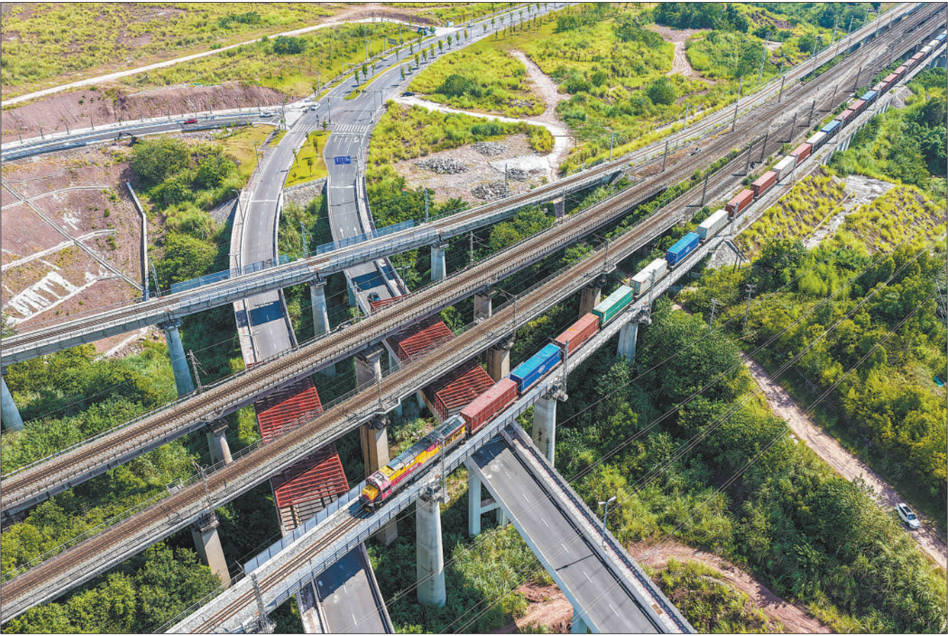
7月30日,西部陆海新通道班列在重庆鱼嘴站发车(无人机照片)。该班列满载的汽车零配件、摩托车配件等产品将发往东南亚市场。
