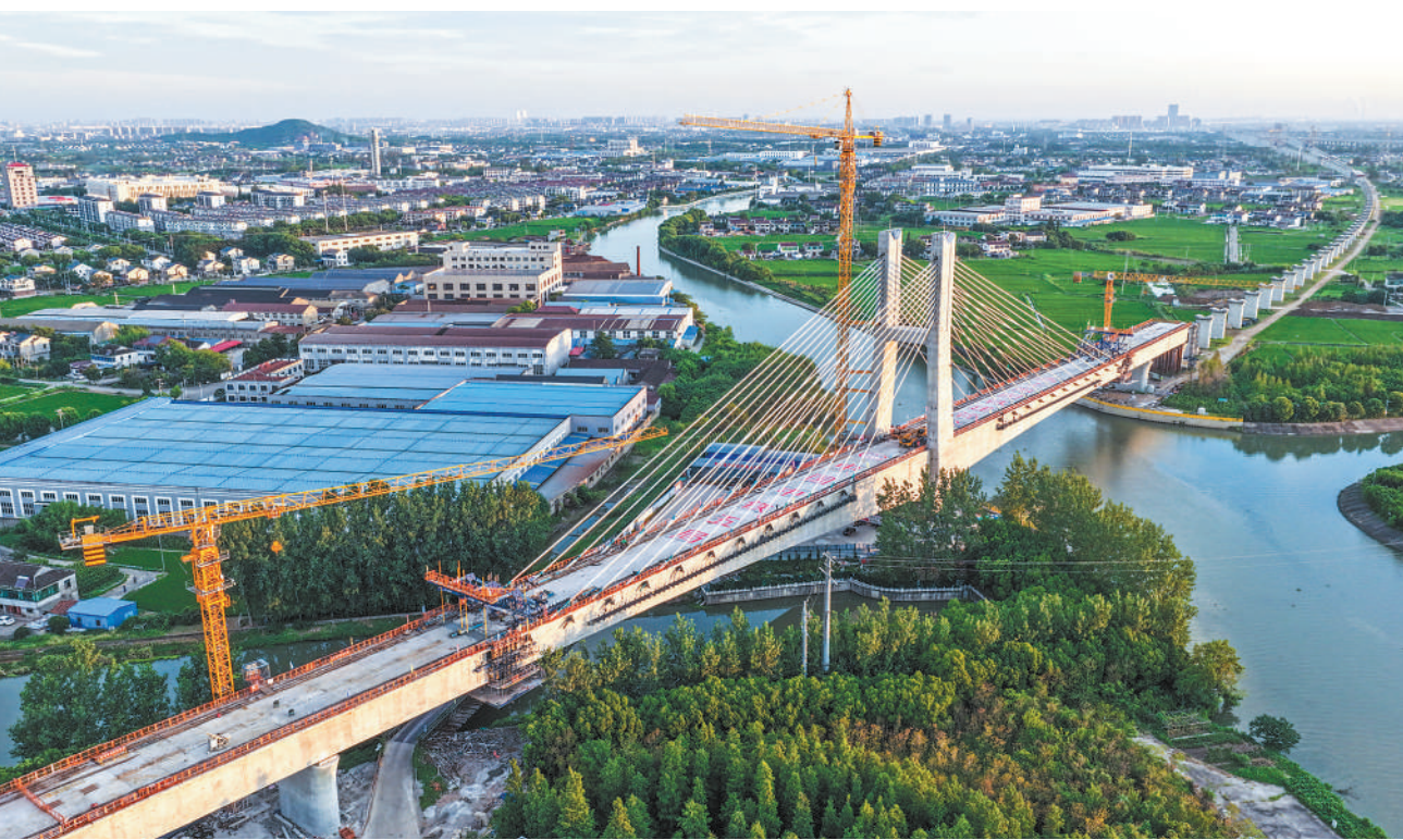
7月29日，通苏嘉甬高铁全线首座斜拉桥——跨张家港河斜拉桥顺利合龙，该桥位于江苏张家港、常熟交界处，总长417.7米。通苏嘉甬高铁是我国“八纵八横”高铁网沿海通道的重要组成部分，建成后将进一步完善长三角地区铁路网结构，推动长三角一体化高质量发展。图为通苏嘉甬高铁跨张家港河斜拉桥。
