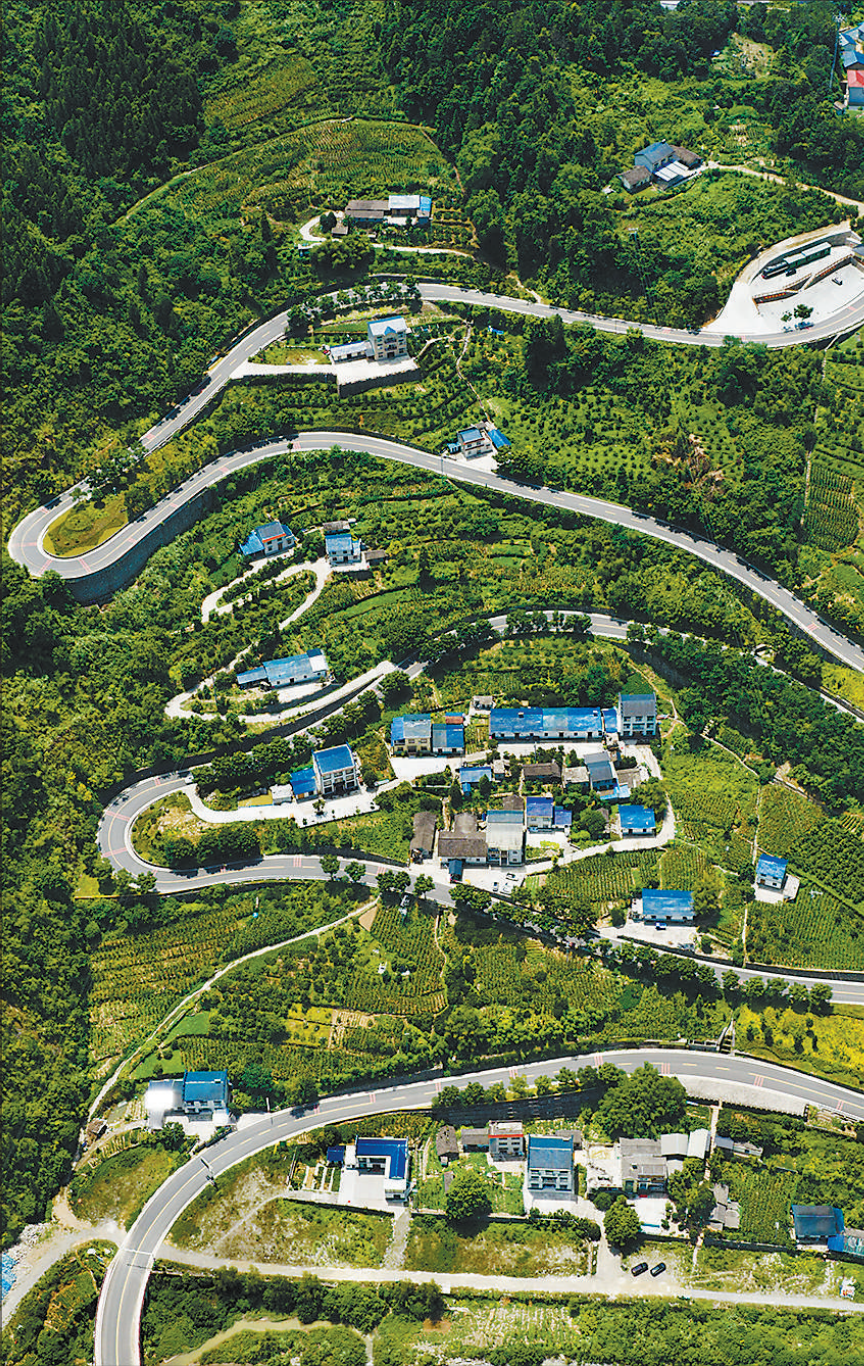
日前，湖北省宜昌市秭归县的茅荃公路蜿蜒穿过槐树坪村。近年来，秭归县加强道路建设，有效推动乡村旅游发展，助力乡村全面振兴。 郑 坤摄（影像中国）
