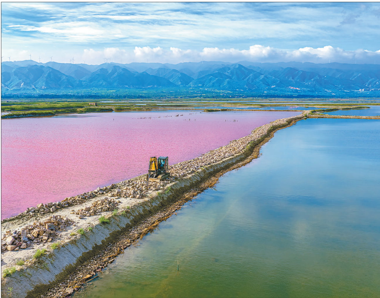
7月28日，山西省运城盐湖堤险除险加固及生态修复项目加紧施工。工程机械穿梭在盐湖边，开展堤险修整加固作业，为这片古老盐池筑牢安全屏障，守护盐湖独特的生态资源。
