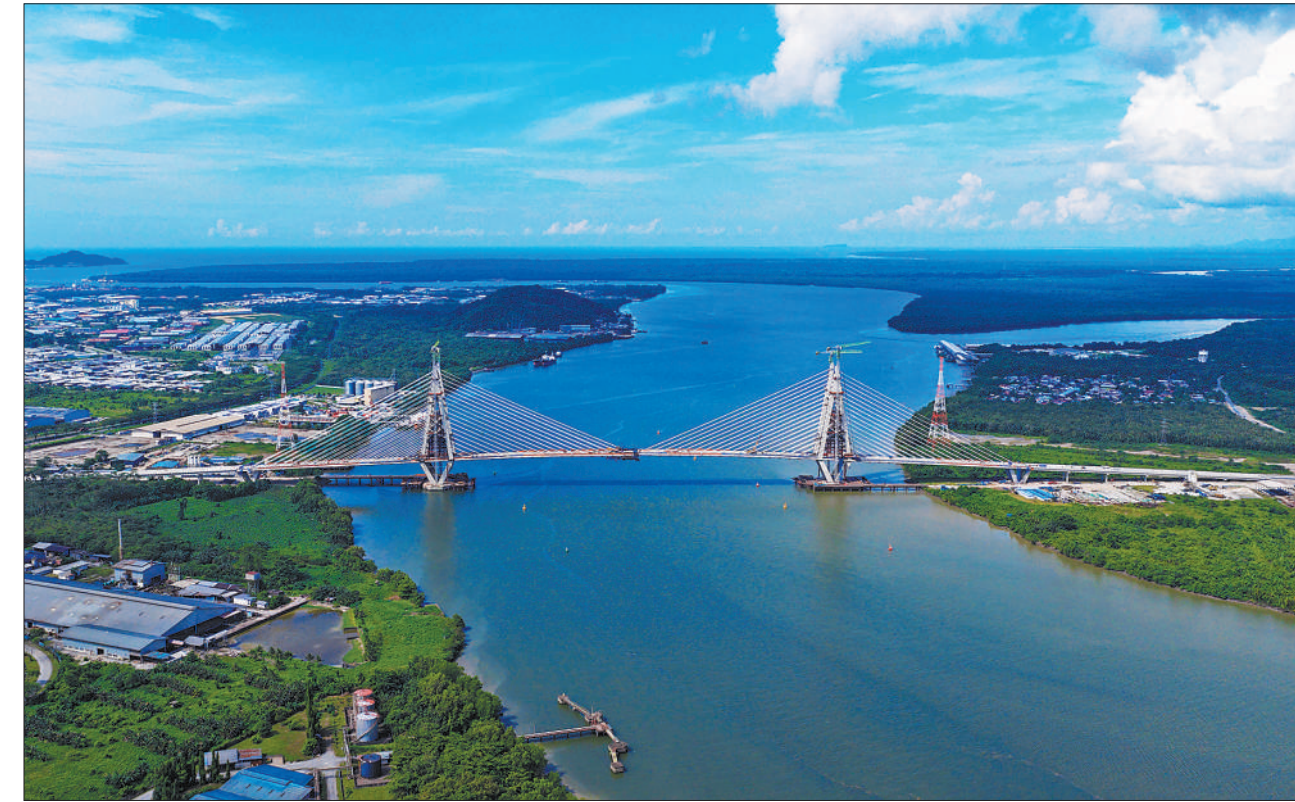
近日，由中国港湾承建、中交二公局具体实施的马来西亚沙撈越塞京卡特大桥顺利完成中跨合龙。大桥位于沙撈越州首府古晋，全长1281.2米、塔高119.06米，是世界最大跨径竖琴式双索面双塔混凝土斜拉桥。大桥预计今年内通车，将有效完善古晋城市交通路网，提升通行效率。
