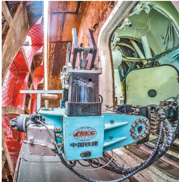
换刀机器人出舱到达作业位置，准备开启换刀作业。 范少文摄
