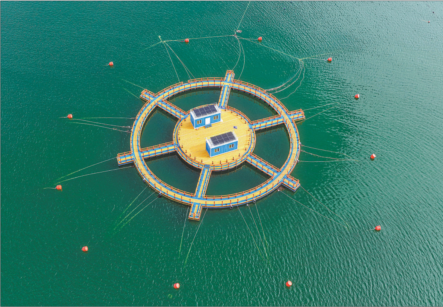
近日，由中国科学院海洋研究所自主研发的近海生态系统野外受控试验平台在山东省荣成市桑沟湾海域投用。作为设施完善的近海海上综合试验平台，它补齐了我国近海原位受控实验设备短板，搭载多套监测调控模块，可开展多元生态模拟试验。平台面向全球科研单位开放，可助力海洋生态修复、渔业升级，赋能海洋经济高质量发展。图为7月20日在桑沟湾海域拍摄的近海生态系统野外受控试验平台。
