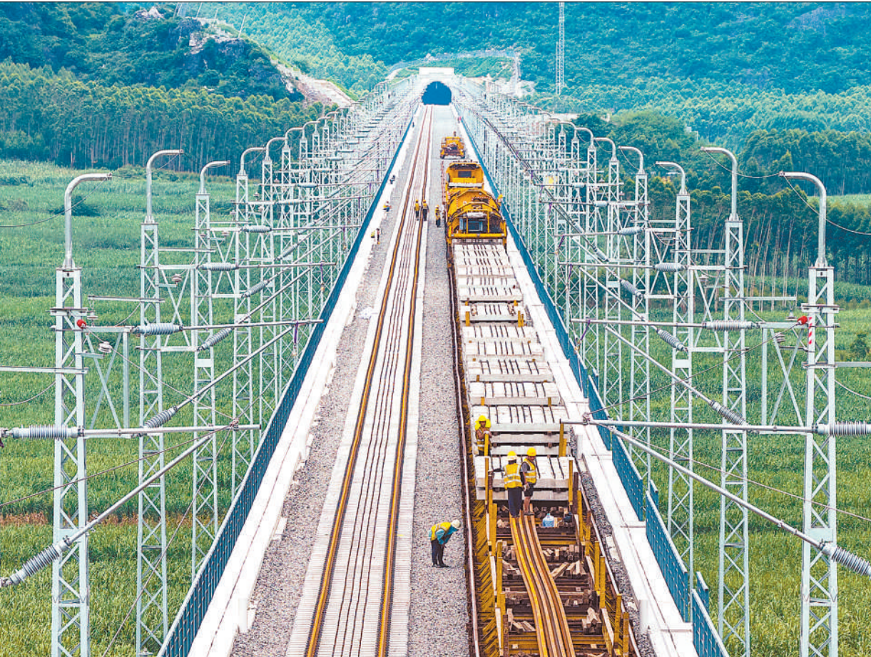
广西柳州至梧州铁路项目建设即将进入冲刺阶段，目前铺轨作业进入来宾市象州县与柳州市柳江区段，全线桥涵、路基、隧道工程基本完工，轨道工程完成超 70%。
