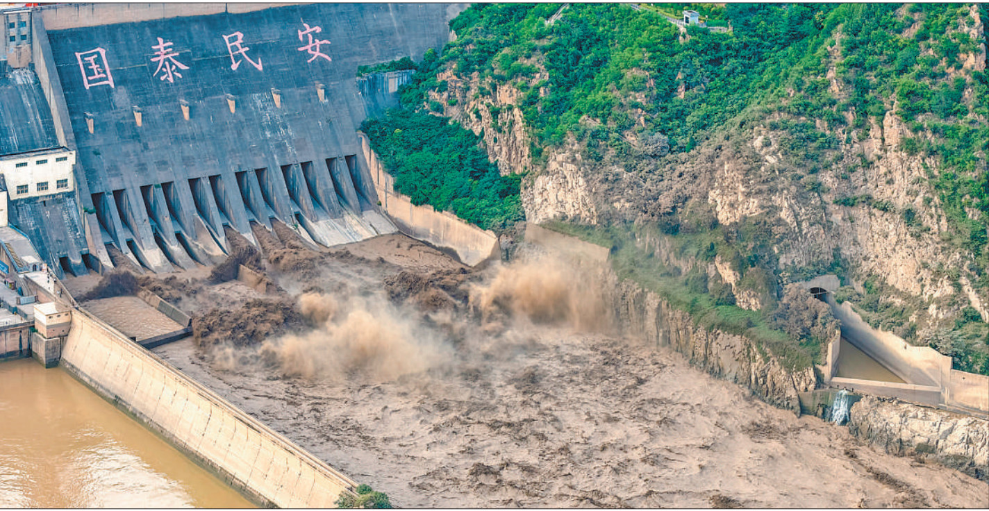
河南三门峡水利枢纽正在进行调水调沙。 孙 猛摄（影像中国）
