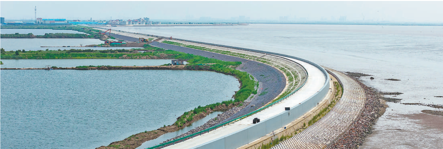
日前，天津市滨海新区防潮海堤一期工程全线完工并具备防潮能力。据介绍，一期工程长3.4公里，对原有坝体进行全方位升级，新堤堤顶高程达9.2米，以应对台风、暴雨与海潮“三碰头”风险。图为7月12日拍摄的防潮海堤一期工程。
