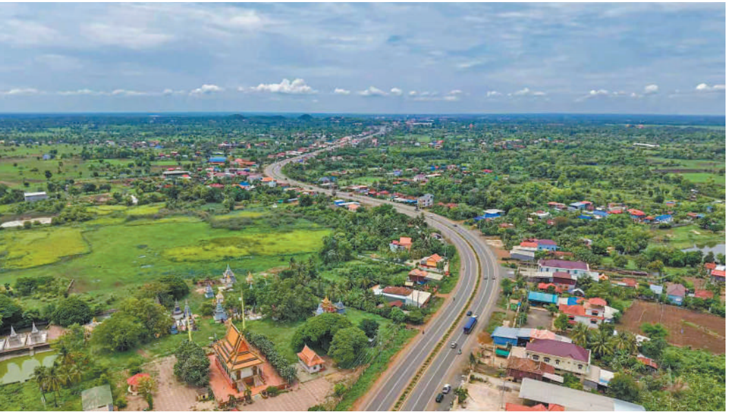
由中国路桥工程有限责任公司承建的东埔寨7号公路（斯昆—磅湛段）升级改造项目竣工通车仪式日前举行。据悉，该公路是柬埔寨首都金边向外放射的8条主干线公路之一，全长45.04公里。项目顺利竣工通车对丰富和完善区域路网结构、改善区域内综合运输能力具有重要意义。 图为7号公路（斯昆—磅湛段）航拍。 白元琪 科伊·切阿莫特摄影报道
