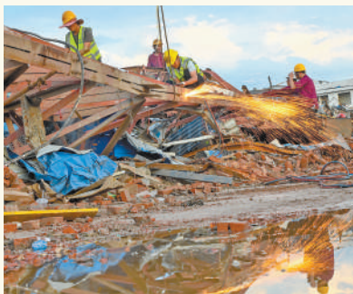
7月7日,湖北黄冈市黄州区受灾物流园内,救援队伍开展清障修缮。 王 江摄(影像中国)
