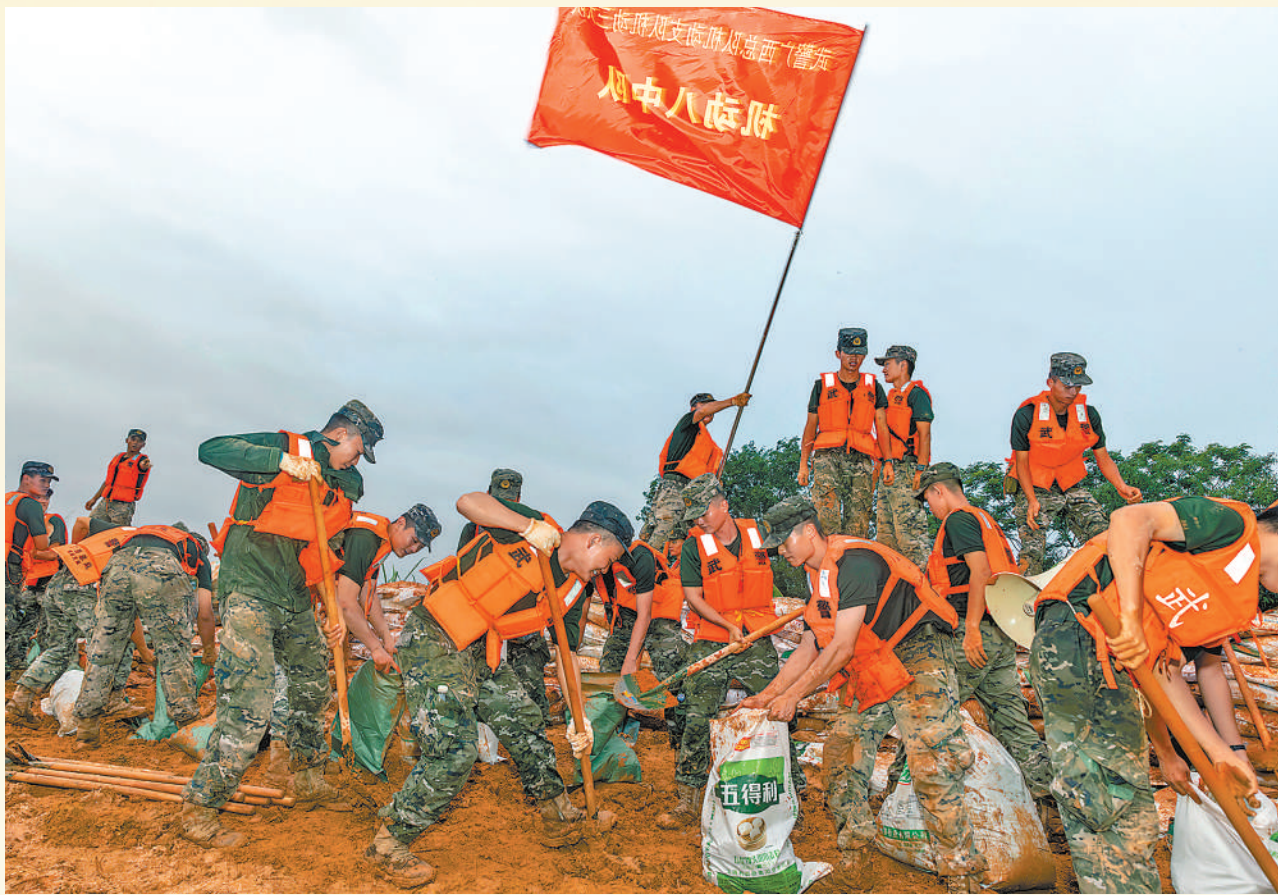
7月7日,武警广西总队机动支队抽调500余名官兵奔赴广西贵港市港北区受灾区域,投入堤坝加固抢险攻坚任务。 刘 明摄(影像中国)
