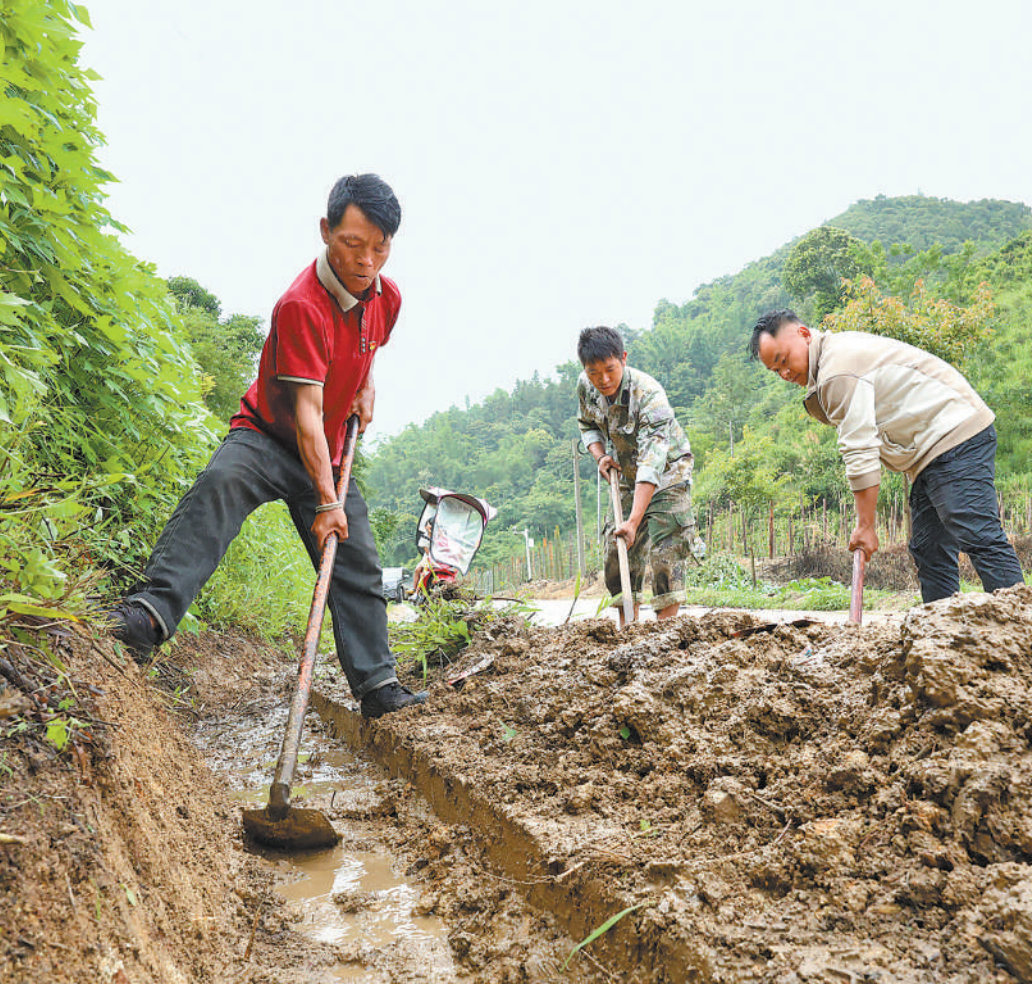
多省份近期迎来强降雨过程,各地广大党员干部冲锋在前,全力筑牢汛期安全防线。图为7月5日,云南省西双版纳傣族自治州勐海县,格朗和哈尼族乡帕沙村党员群众一同清理道路排水沟。
